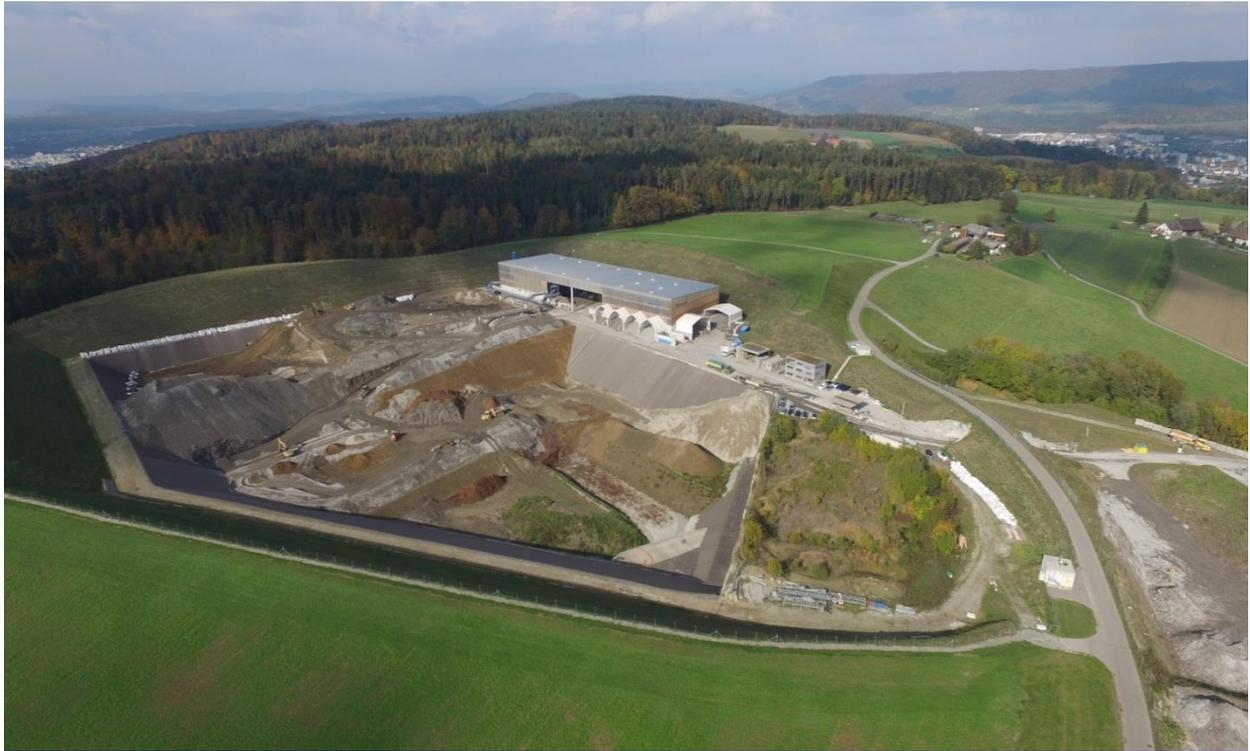
Abbildung 7. Deponie H채uli mit der Aufbereitungsanlage supersort<sup>®</sup> und supersort<sup>®fein</sup>, welche sich in der Halle wettergeschützt direkt neben der Deponie befindet. Ein Forderband fuhrt die entschlottete Schlacke direkt auf die Deponie.
