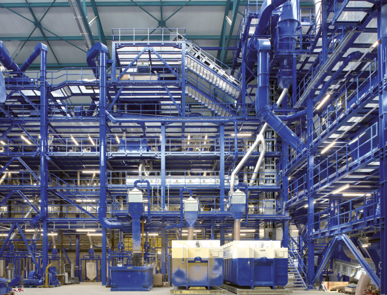
Teilansicht der neuen Metallaufbereitungsanlage «supersort metall».
