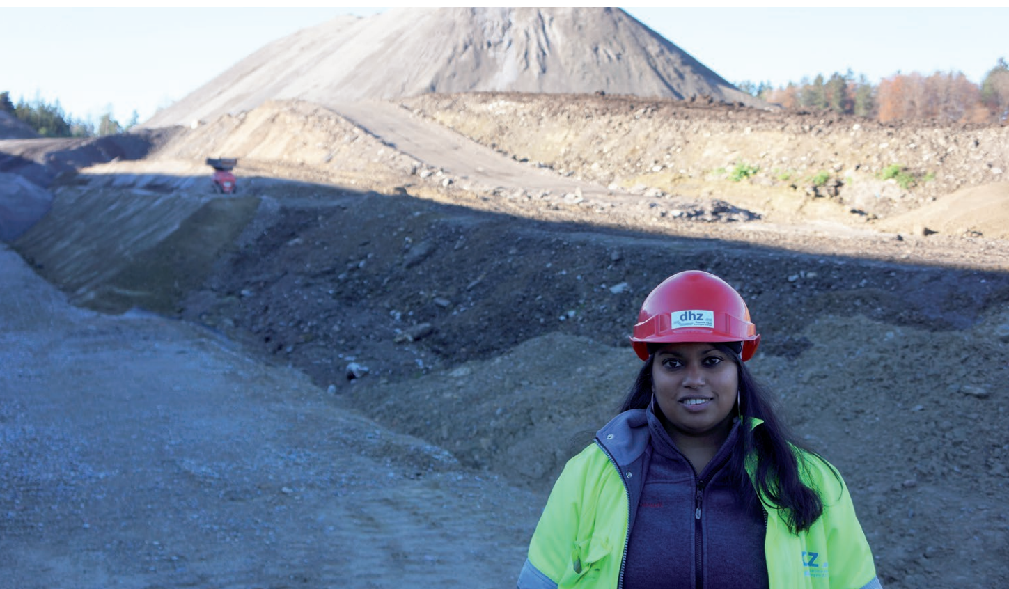
Sneha Fischlin ist für die Entwicklung der Deponie Häuli in Lufingen zuständig, in der Schlacke aus Kehrichtverbrennungsanlagen deponiert wird. (Foto: volltext.ch)
