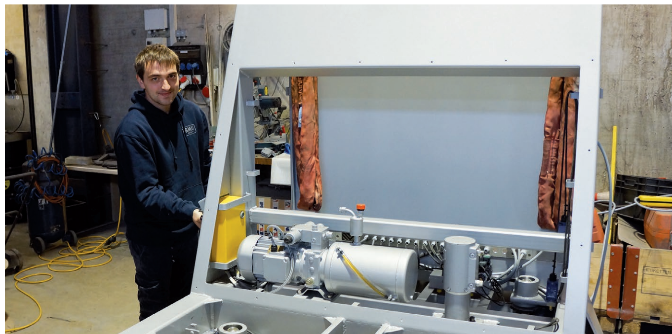
Fabian Jegge führt an einer Befahranlage von BMU Access die Revision durch. (Foto: volltext.ch)
